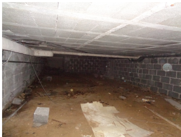
Vue générale plancher poutrelles hourdis
