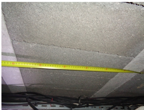
Vue rapprochée entraxe poutrelles
