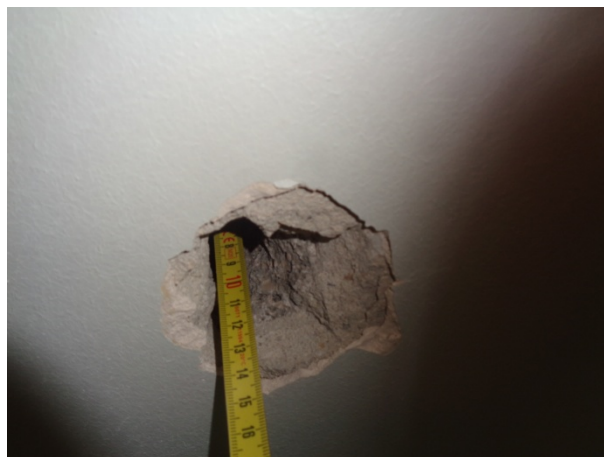
Vue rapprochée épaisseur plancher
