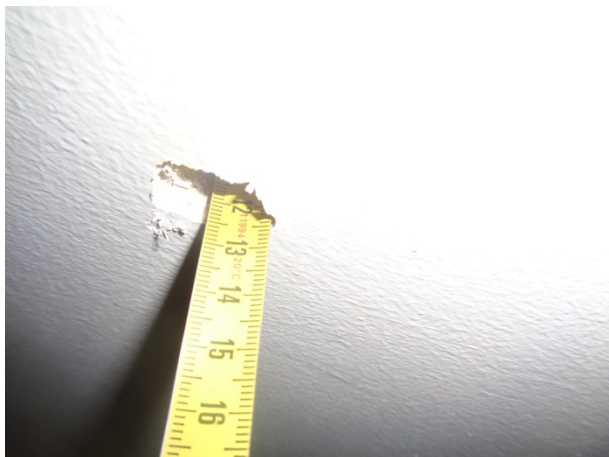
Vue rapprochée épaisseur plancher
