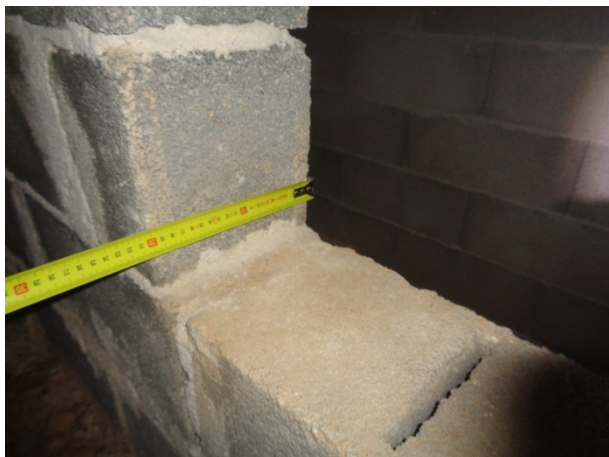
Vue rapprochée épaisseur voile de refend
