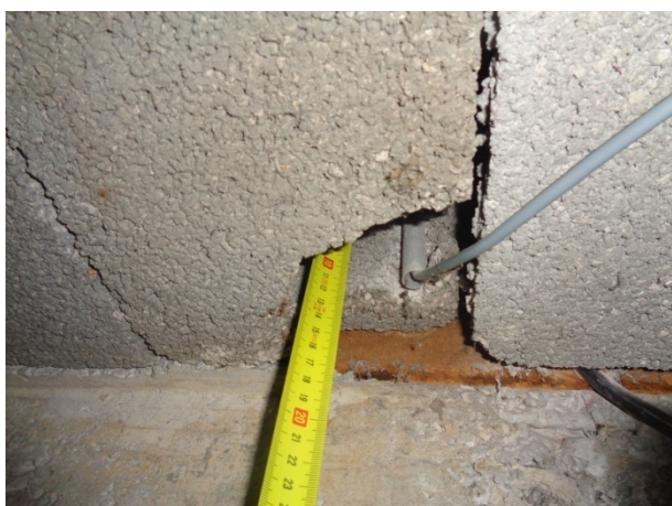
Vue rapprochée hauteur poutrelle
