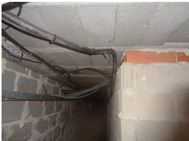
Vue générale plancher poutrelles hourdis
