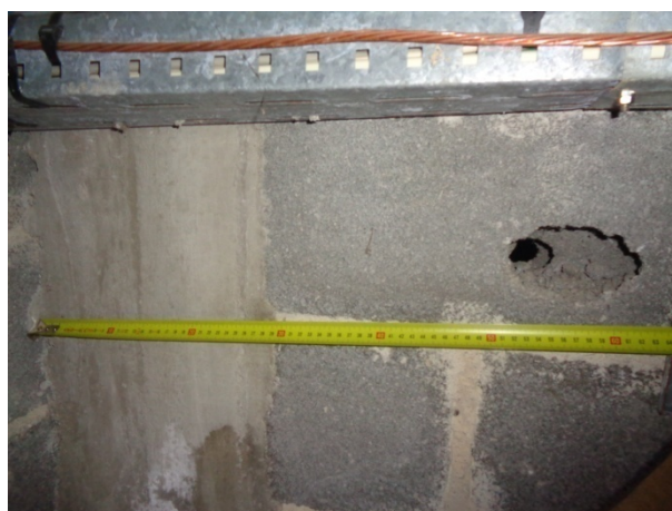
Vue rapprochée largeur poteau béton
