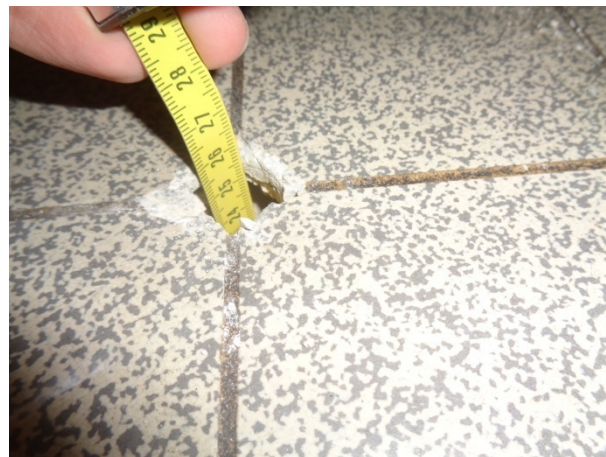
Vue rapprochée perçement sur plancher
